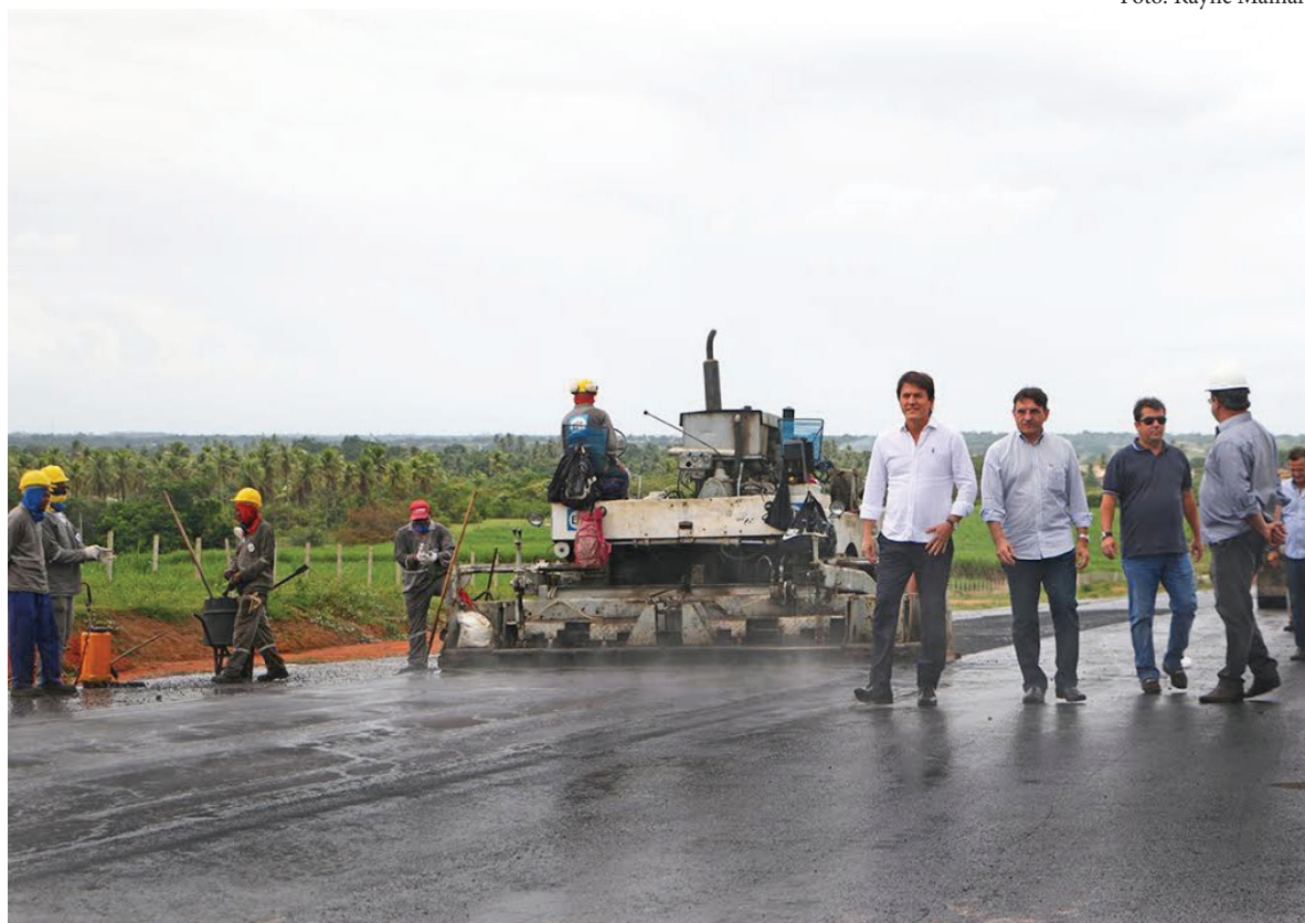
Entre os objetivos da concessão estão: Conclusão das obras do Contorno Sudoeste da região metropolitana e implantação de melhorias nas rodovias
